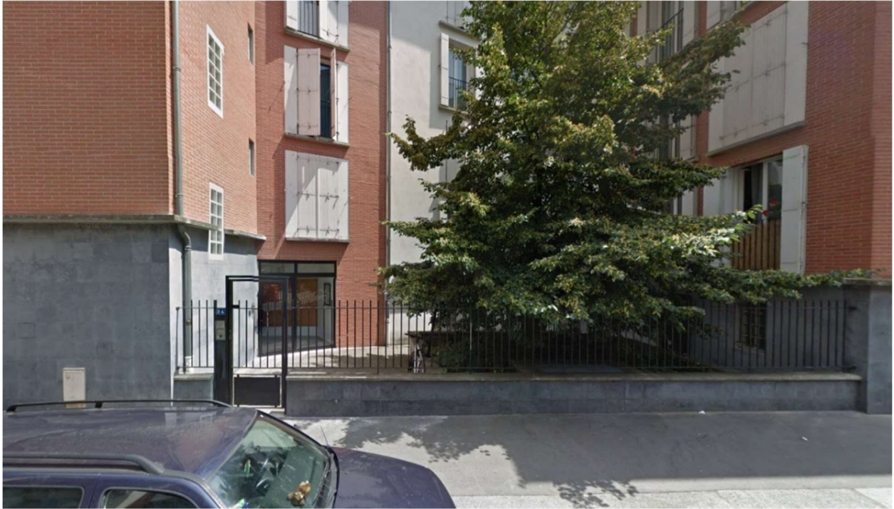
Rue du Dessous des Berges, Paris
